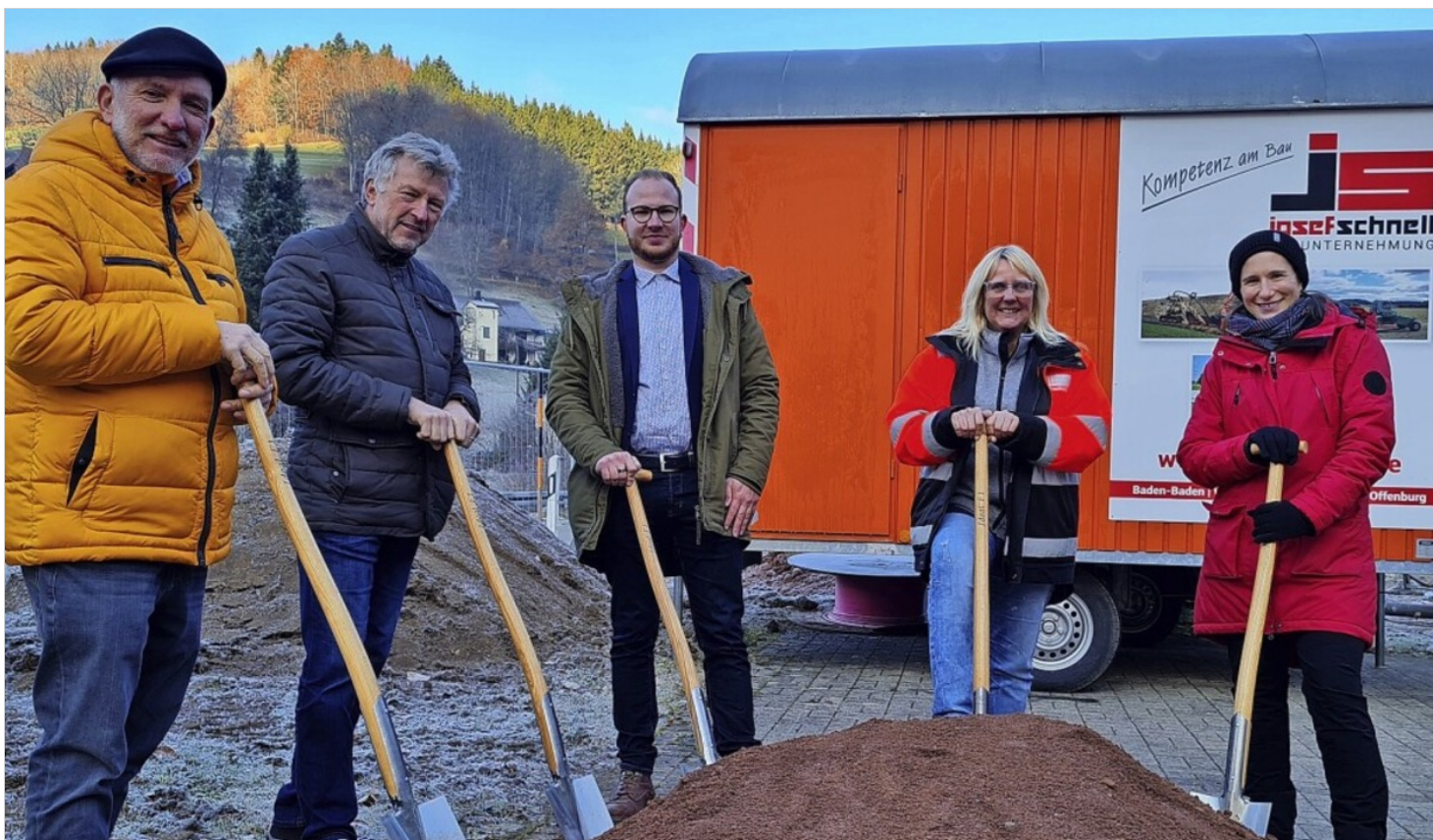
Beim Spatenstich für den nächsten Bauabschnitt der Breitbandverkabelung im Kleinen Wiesental in Bürchau: Axel Moick, Bürgermeister Gerd Schönbett, Bauleiter Christoph Zehnle, Andrea Böcherer und Ortsvorsteherin Katharina Matzken. Foto: Gerald Nill
